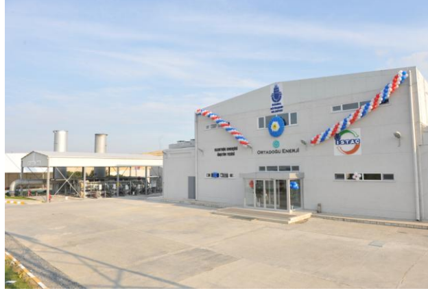
Şekil 6. İstanbul Odayeri Enerji Üretim Tesisi
