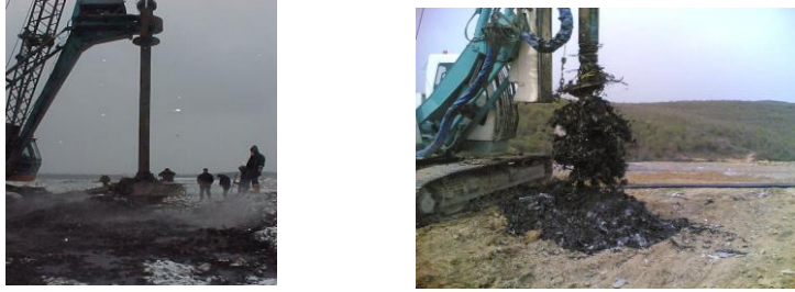
Şekil 3 Gaz Pompaj Testi Çalışmaları
